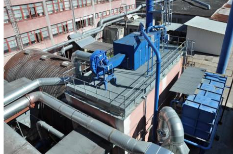
Doplňení spalovací jednotky RTO o rotační zeolitový koncentrátor VOC – viz obrázek spalovací jednotky RTO vlevo
