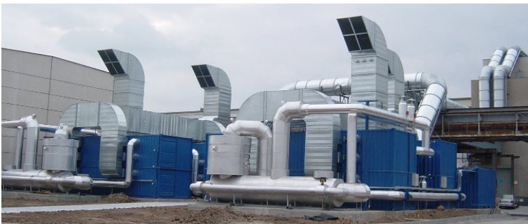
Katalytické spalovací jednotky VOC s koncentrací VOC na pevných ložích AU – realizace v rámci dodávky lakoven kolejových vozidel – kapacita 2 x 100.000Nm 3 /hod – výroba kolejových vozidel
