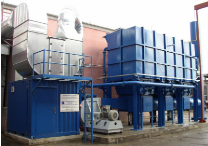
Spalovací jednotka regenerativní termické oxidace VOC – rekonstrukce a ekologizace lakovacích prostorů dřevěných dílů – kapacita 22.000Nm 3 /hod
