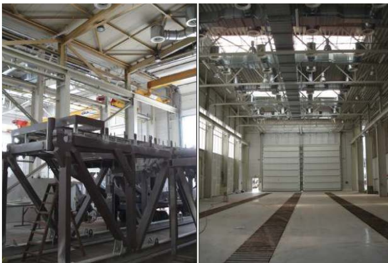
Obr. 6 - Volná lakovací plocha výrobní haly obsluhovaná manipulačně mostovými jeřáby jezdícími pod distribučním potrubím přívodního čerstvého vzduchu se stropními tryskami (stříbrné potrubí nahoře se stropními tryskami) a kolejovým vozem jezdícím po kolejkách určených pro zavážení do původní zrušené uzavřené lakovací kabiny
