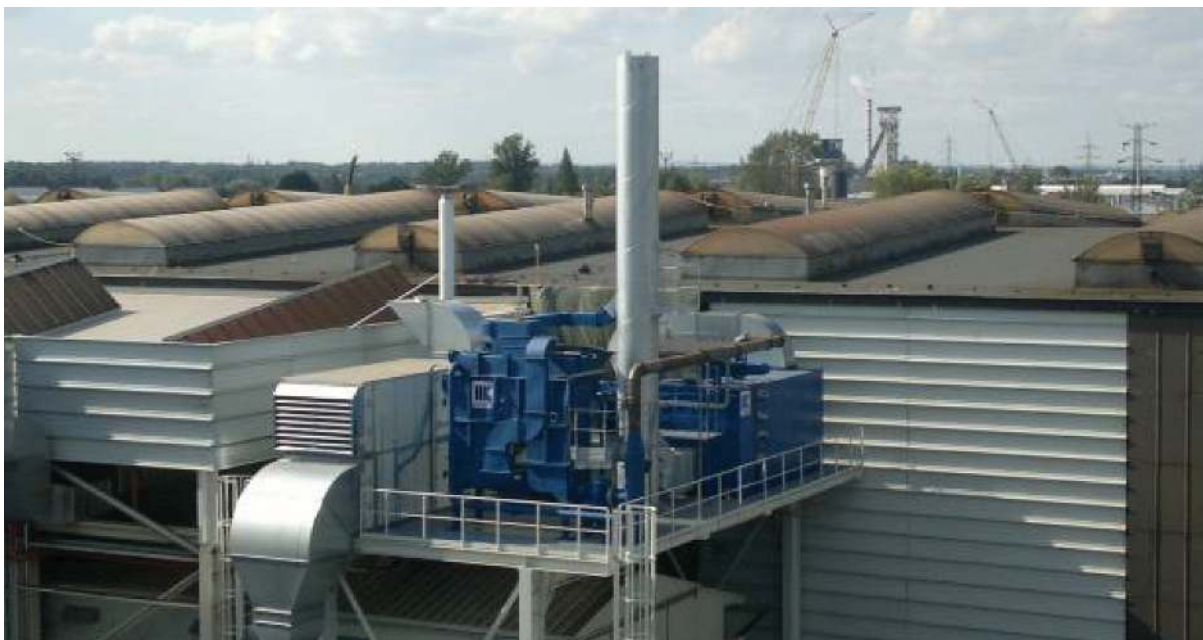
Obr. 14 - Technologie likvidace emisí VOC se spalovací jednotkou regenerativní termické oxidace s koncentrací VOC na zeolitovém rotačním koncentrátoru pro likvidaci emisí VOC z haly lakovny ocelových konstrukcí (viz shora obr. 7 až 9). Technologie je umístěna, z prostorových důvodů, na ocelové konstrukci ve výšce cca 8 m
