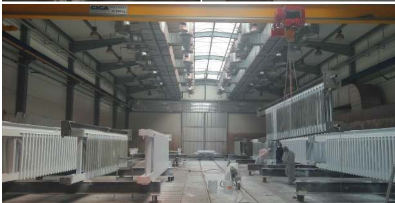
Obr. 7, 8 a 9 - Realizace lakoven velkorozměrových dílců se sekční ventilací na volné ploše výrobní haly
