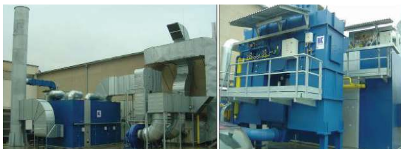
Obr. 4 a 5 – Technologie likvidace emisí VOC, vlevo sekce zeolitového rotačního koncentrátoru s pomocným ohřevem, vpravo spalovací jednotka typu regenerativní termické oxidace (RTO)
