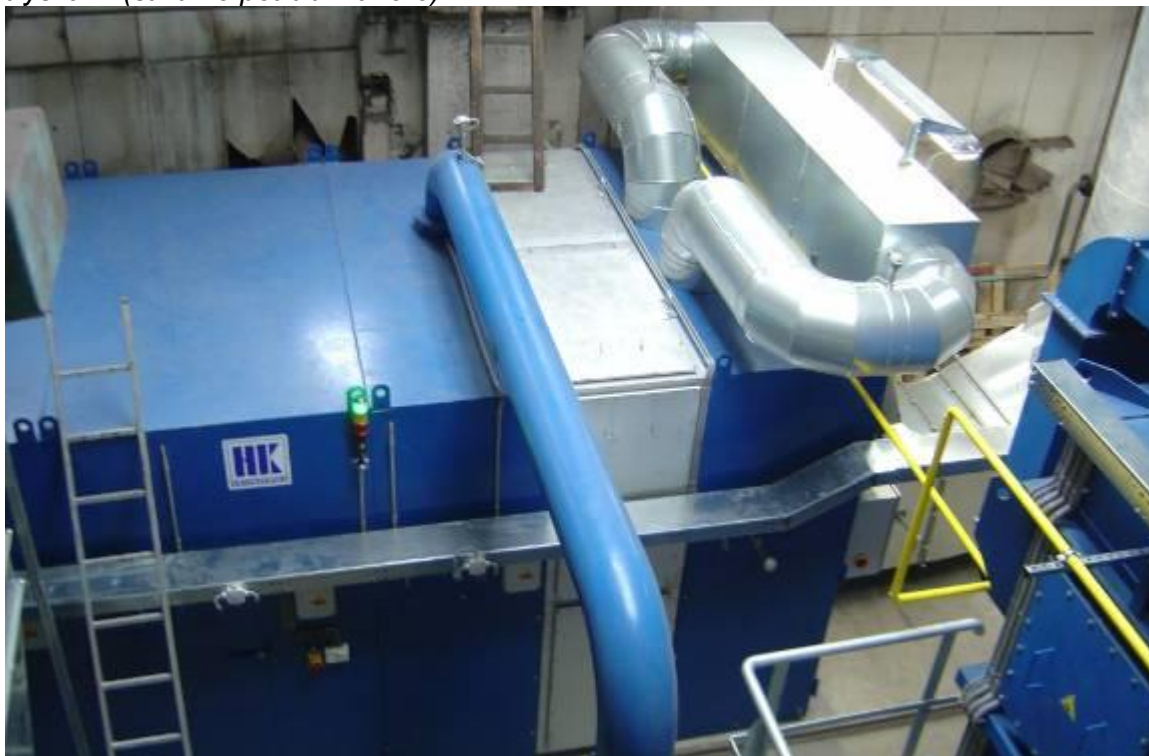
Technologie likvidace emisí VOC s předkoncentrací VOC na zeolitovém rotačním koncentrátoru a regenerativní spalovací oxidační jednotkou (RTO s pomocným desorpčním ohřevem) umístěná ve vnitřním prostředí prodanou lakovnu. Objem vstupující znečištěné vzdušiny cca 40.000Nm 3 /h.
