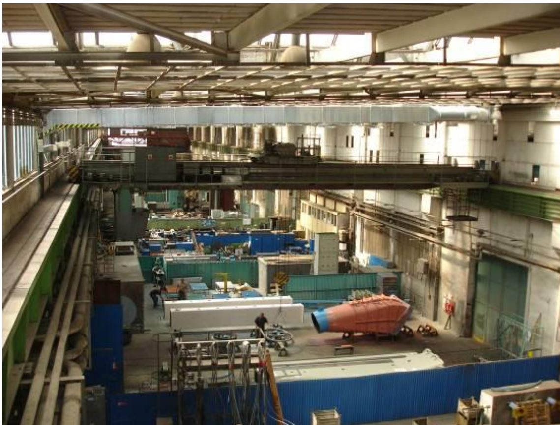
Volná lakovací plocha výrobní haly obsluhovaná manipulačně mostovými jeřáby jezdícími pod distribučním potrubím přivodního čerstvého vzduchu se stropními tryskami (stříbrné potrubí nahoře).
