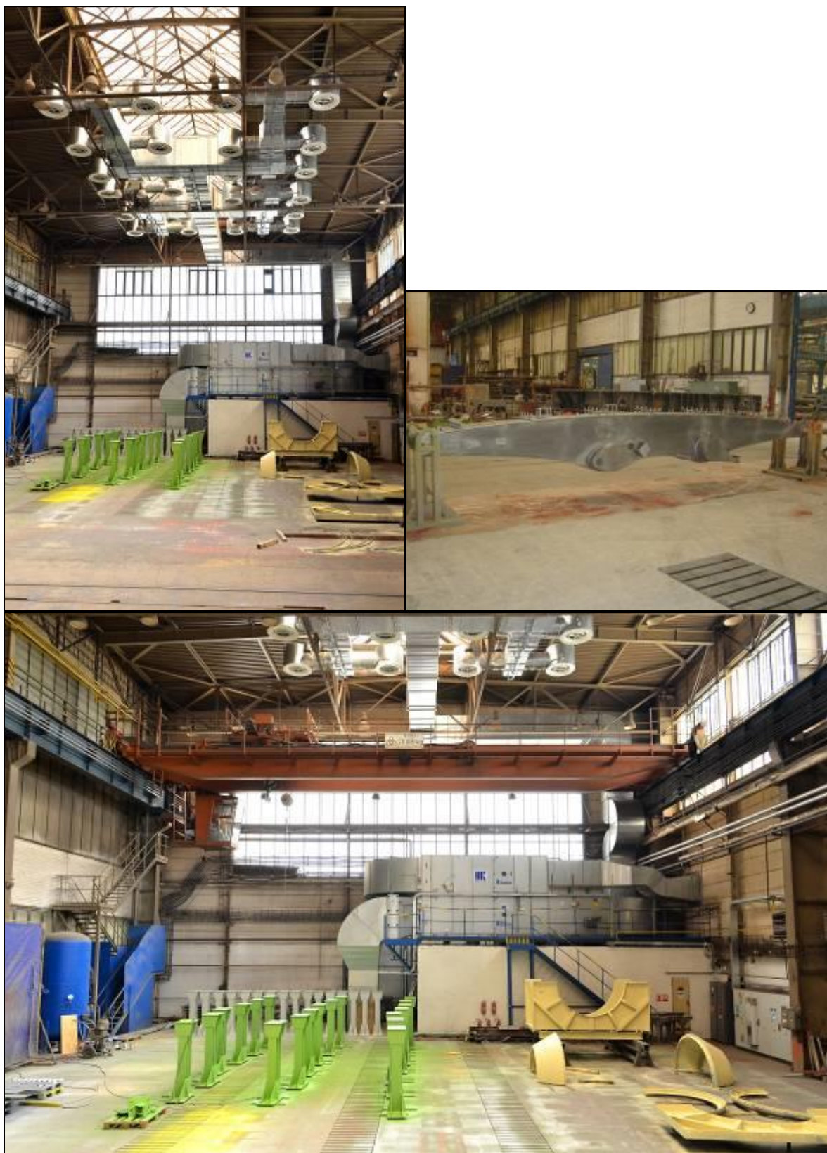
Realizace lakovny velkorozměrových dílců se sekční ventilací na volné ploše výrobní haly.
