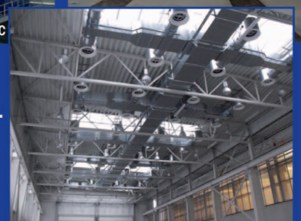
Výrobní hala nové lakovny
